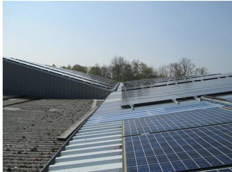
Abb. 1: Zugang zum Arbeitsbereich der Dachdecker
