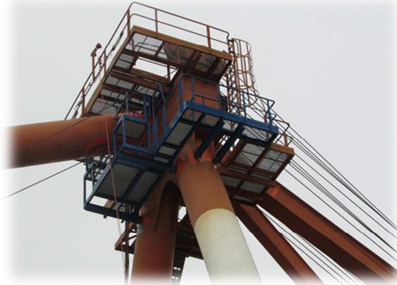
liche visuelle Prüfung der stark beanspruchten Punkte einmal im Monat vor. Bei dieser Prüfung werden die Schweißnähte der Rohrverstreibungen nicht nur von außen begutachtet, sondern auch durch neu geschaffene Zugänge mittels Endoskope von innen. Hier wurden im Sommer 2016 wieder Rissbildungen festgestellt. Der Betreiber lies hierauf die Containerbrücken wieder stilllegen. Es wurde ein weiteres Reparaturkonzept mit den Sachverständigen und dem Hersteller
