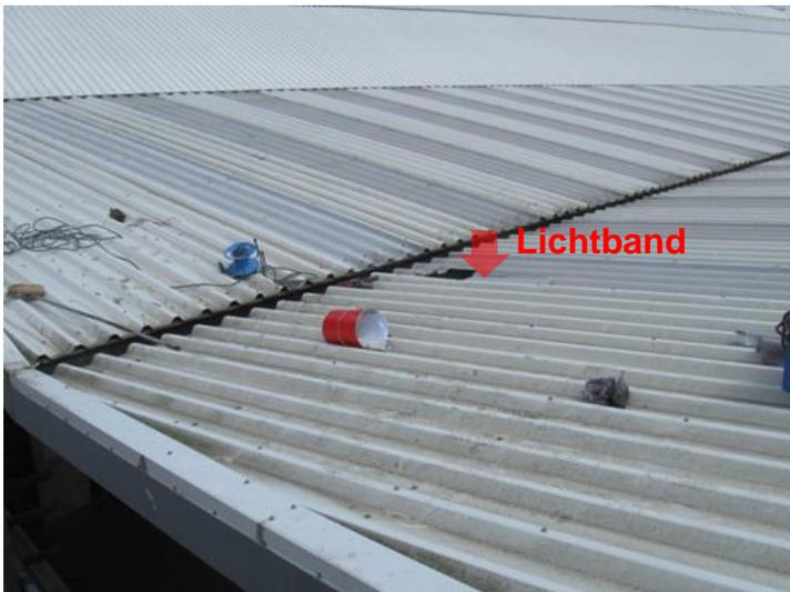
Abb. 4: Darstellung des Daches von oben mit Absturzstelle und Lichtband
