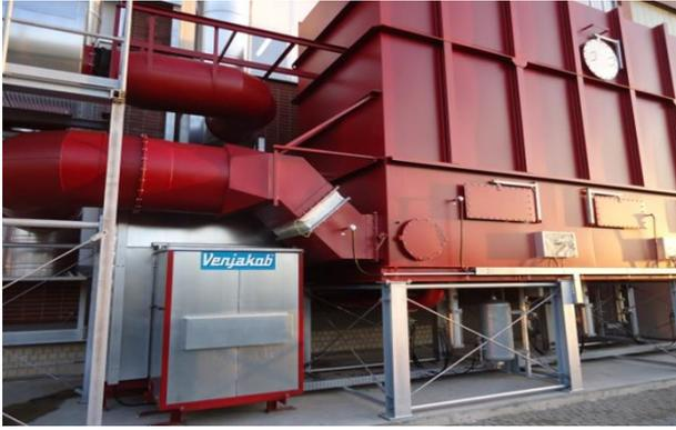
Abb. 26: Drei-Kammer-Wärmetauscher
