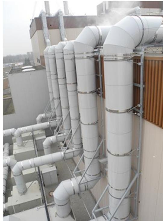
Abb. 25: Ab- und Zuluft-Leitungen zu den Biofiltern
