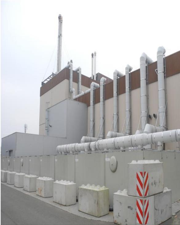
Abb. 24: Container als Biofilter
