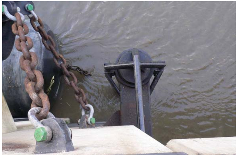
Abb. 13: Gesicherter Pfahlkopf (Draufsicht)
