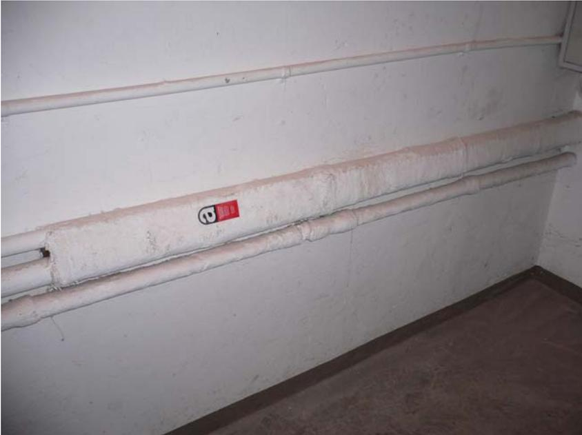
Abb. 19: Asbestrohrleitung
