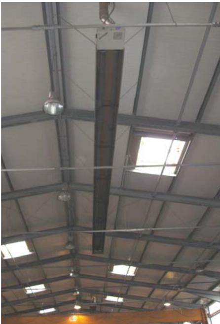
Abb. 11: Dunkelstrahler-Heizung in der Werkhalle
